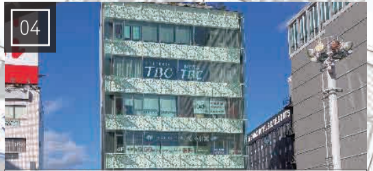
注目：ビルがガラス張りになっている 印象：何の店があるかわかりやすい
