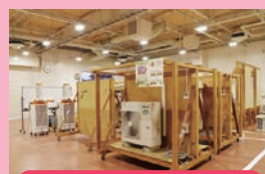
S101 設備実習場
