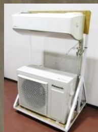
エアコン施工
