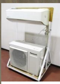
エアコン施工
