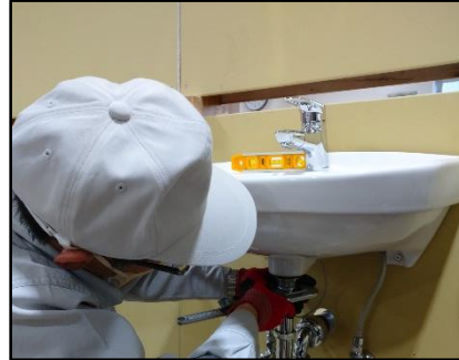
給排水設備の訓練内容の説明
