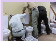
給排水衛生設備
