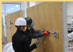
電気工事Ⅱ
