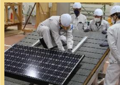
太陽光システム工事 ・住宅配線
