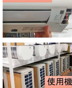
エアコン取付
