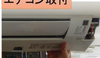
エアコン取付
