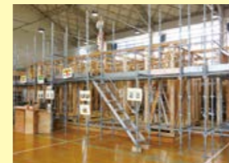
▲木造住宅の新築工事
