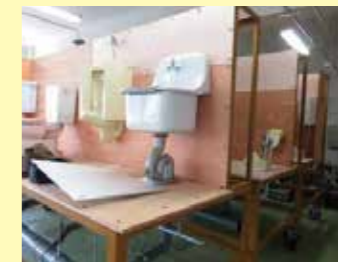
▲衛生設備の取り付け
