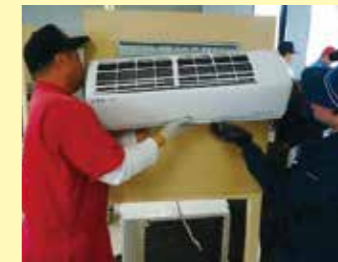
▲エアコンの取り付け
