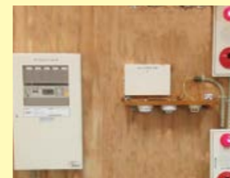
▲自動火災報知設備の構成
