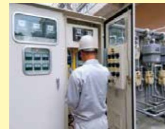
▲受変電設備の点検
