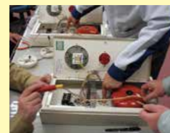
▲消防設備の施工
