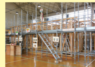
▲木造住宅の新築工事
