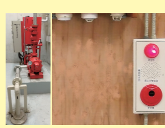
▲自動火災報知設備の構成
