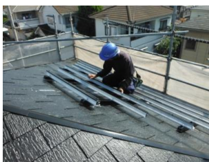
担当物件の施工現場①
