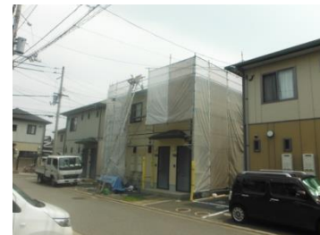
担当物件の施工現場②
