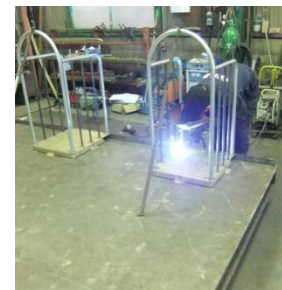
滑り台の溶接作業
