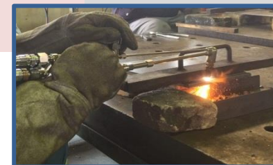
(ガス切断作業)
