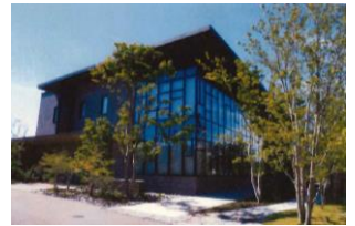
本社社屋 ZEB(ゼロエネルギービル)
