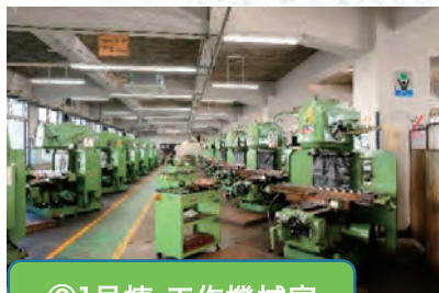
⑥1号棟 工作機械室
