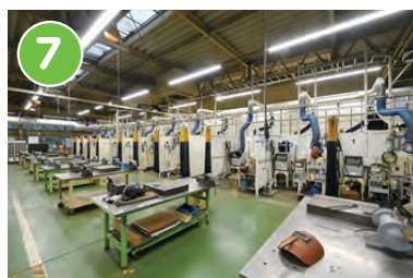
3号棟 溶接実習場
