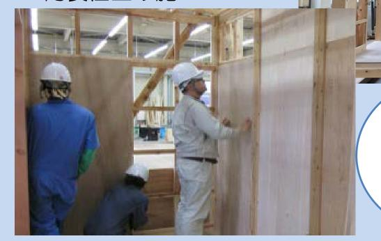
この訓練では、実習場内にある模擬家屋の床・壁・天井を仕上げます。 構造部材加工技術の訓練で学んだことを生かし、 下地材の施工および仕上げ材の施工を行います。
