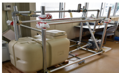
図 3 ポンプ負荷実習装置
