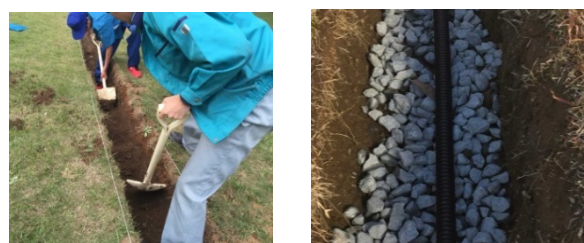
図3 掘削作業と管路の埋設状況
