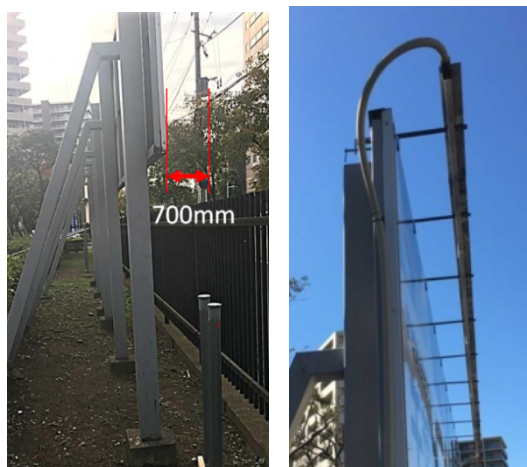
図4 看板への照明の取り付け
