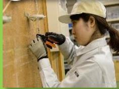
電線を保護するための管工事の手法を習得します。また、自動火災報知設備の法規・設計・施工技術を習得します。
