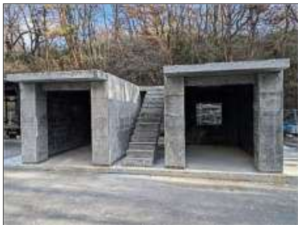
図 15 脱型後の全体
