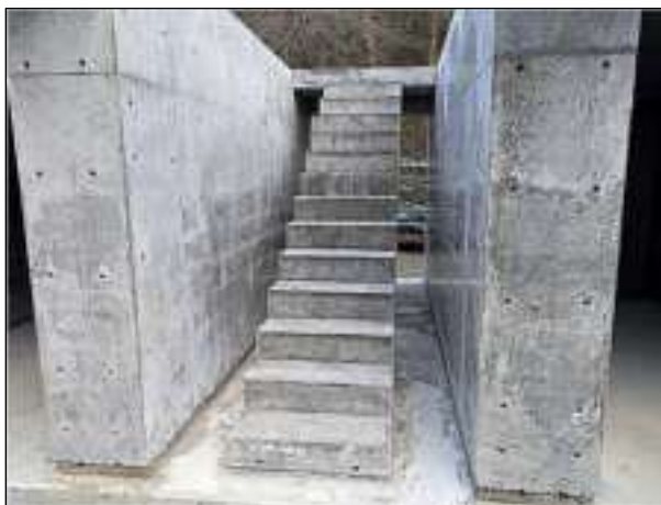
図 16 脱型後の階段
