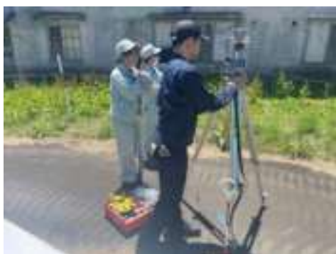
図6 第1回実測調査(水準測量)
