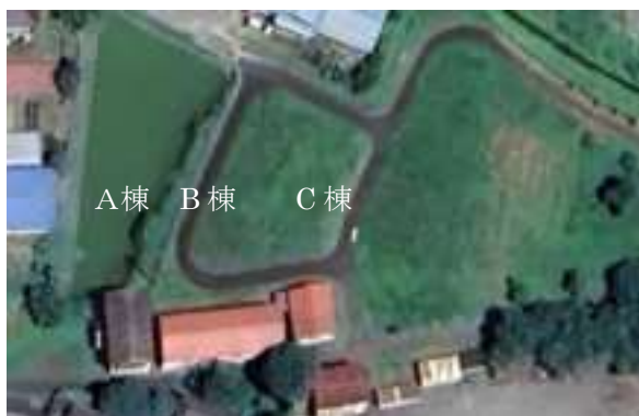
図 3 建築物の配置 敷地住所：岩手県紫波郡
