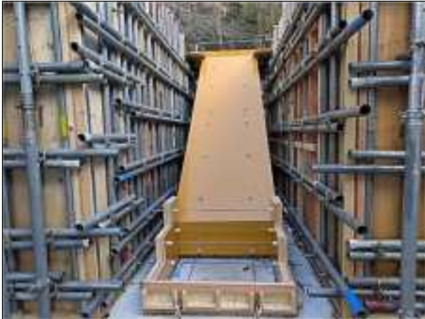
図 11 底板パネルの施工状況
