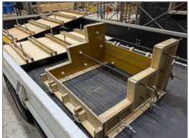
図10 底板パネルと側面パネル(1~3段)
