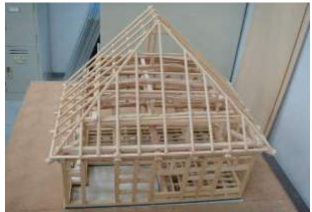
図11 母屋構造復元模型(小屋組)
