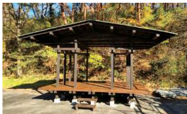
図 6 移設後の休憩所(2024/12/02)
