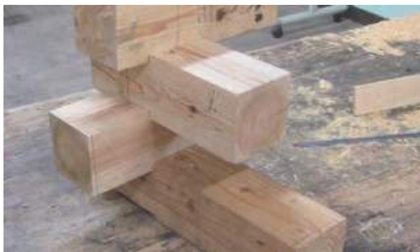
図 2 試作した仕口(2012/11/09)
