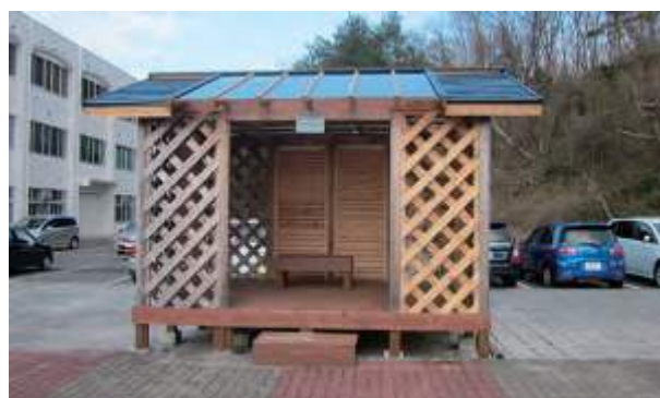
図 1 既存の休憩所 (2012/04/18)
