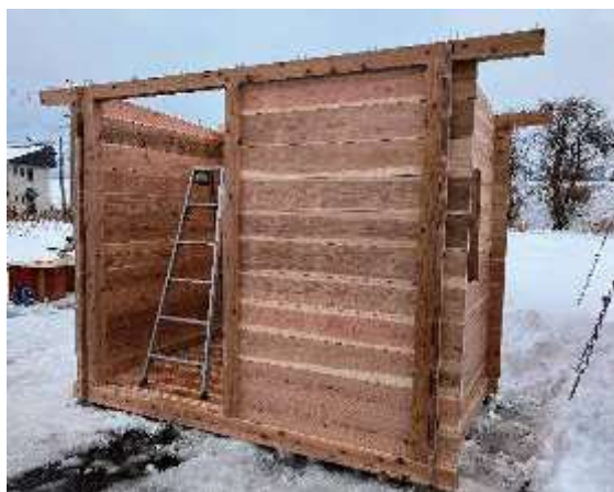
図3 建て方初日の倉庫
