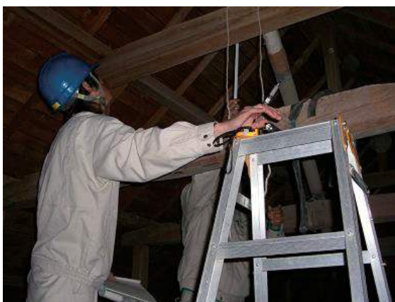
図4 長屋門小屋裏(小屋組み)の実測調査
