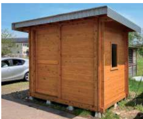
図6 塗装後の倉庫
