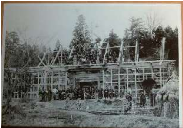
図 7 保存されていた上棟写真(大正 8 年頃)
