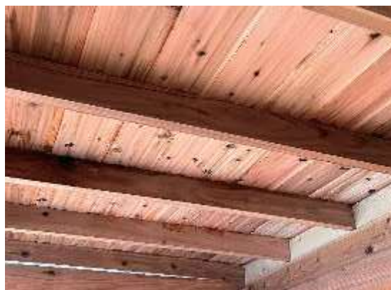
図4 内部から見える野地板
