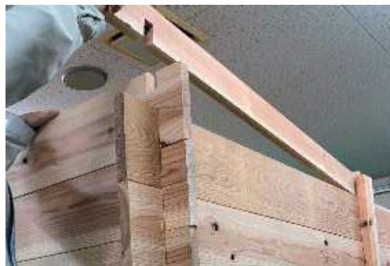
図 2 カフェ板による壁の組立て
