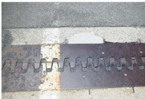
橋桁の遊びの部分
