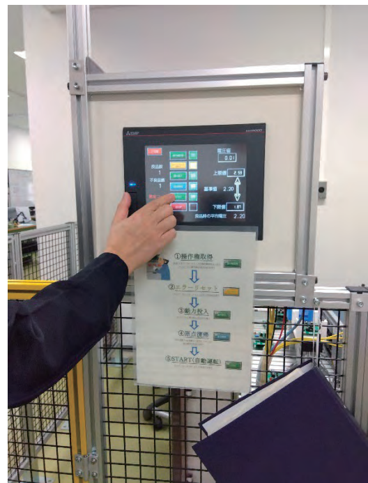
図 12 表示器の設置状況
