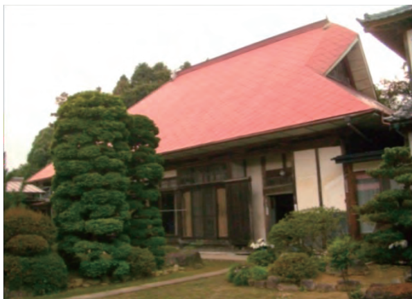
図1 I.T家母屋外観(寄棟屋根一部入母屋造)
