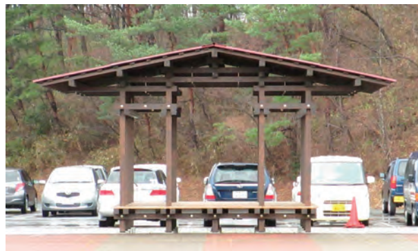
図 3 改修後の休憩所(2013/04/03)
