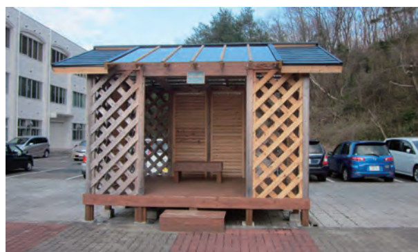
図 1 既存の休憩所(2012/04/18)
