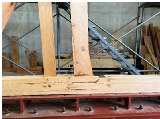
図10 中柱柱脚部の土台破壊状況
