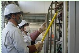
受変電設備の機器の仕様、配線図、測定器の使い方及び試験手法に関する知識及び技能・技術を習得します。
