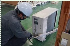
屋内照明取付のための電気配線施工や空冷式エアコンの取り付けなどの知識及び技能・技術を習得します。
