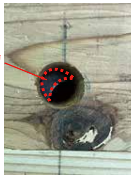
図 15 孔のずれ
