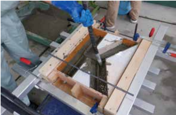
図 4 文字部コンクリート打設
