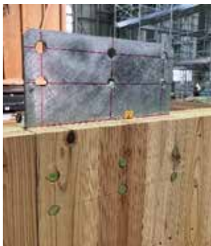
図 14 接合部の加工
