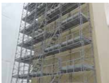
図6 組立てた足場模型 (部分)
