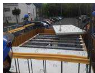
図 2 ハーフ PCa の設置
