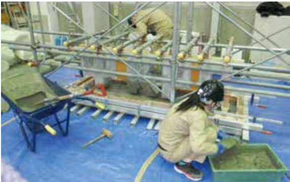
図 5 ベース部コンクリート打設
