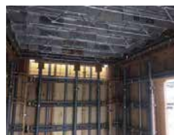
図 3 支保梁の設置
