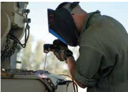
被覆アーク溶接作業
