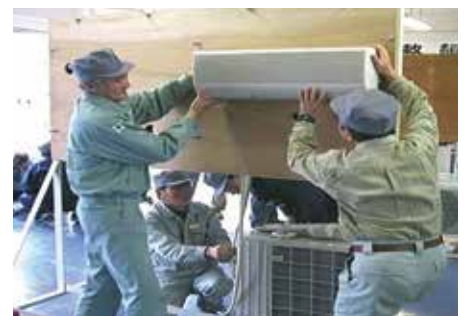
空調設備管理作業
