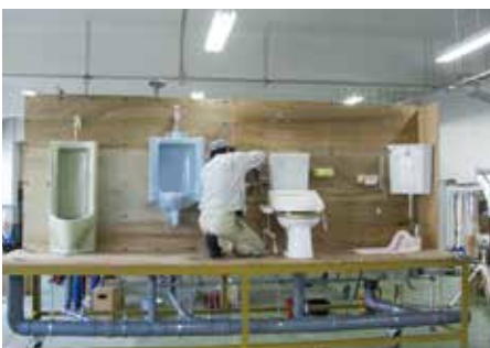
給排水衛生設備作業
