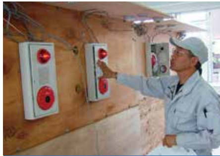
消防設備保全部作業
