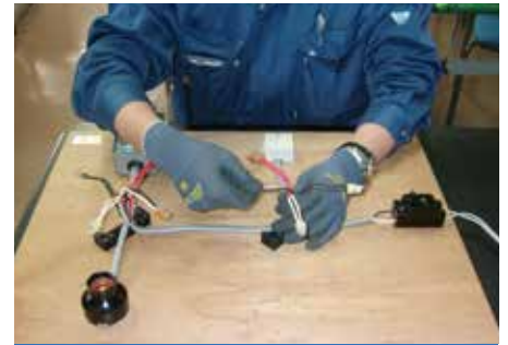
電気工事配線作業
