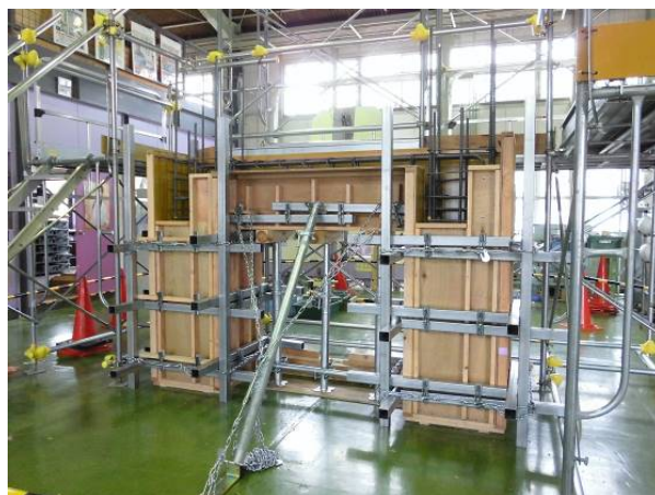
写真1 建築施工実習Ⅱの施工完了状況
