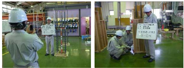
(柱筋の検査)
