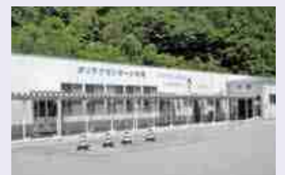
① 本館 (多目的ホール)
