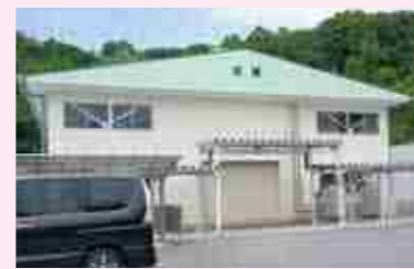
② 金属実習場 (溶接クラフト科)
