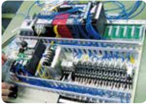
制御盤製作実習
