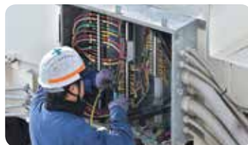
電線接続作業
