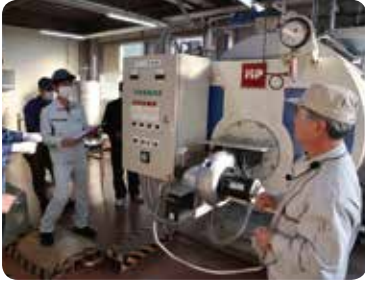
ボイラー運転実習
