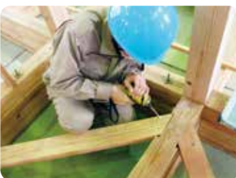
躯体施工作業
