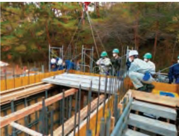
図7 ハーフ PCa スラブの建込(1枚目)
