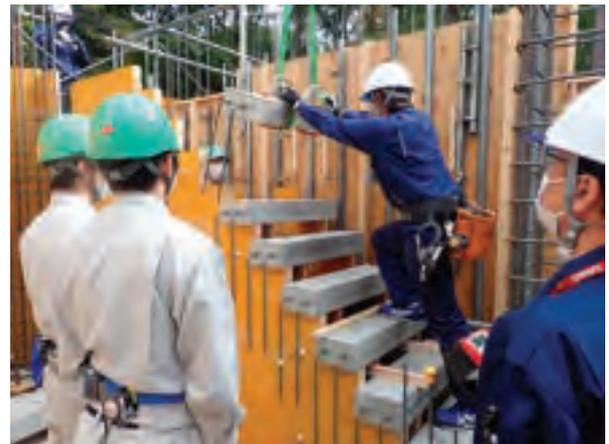
図9 PCa 階段の建込(4 段目以降)
