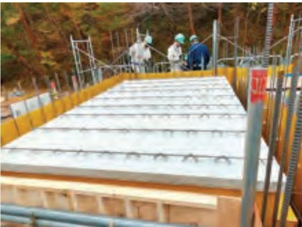
図8 ハーフ PCa スラブの建込完了
