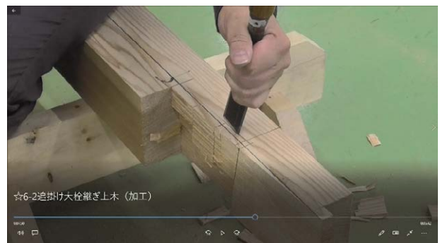
図3 6-2 追掛け大栓継ぎ上木加工
